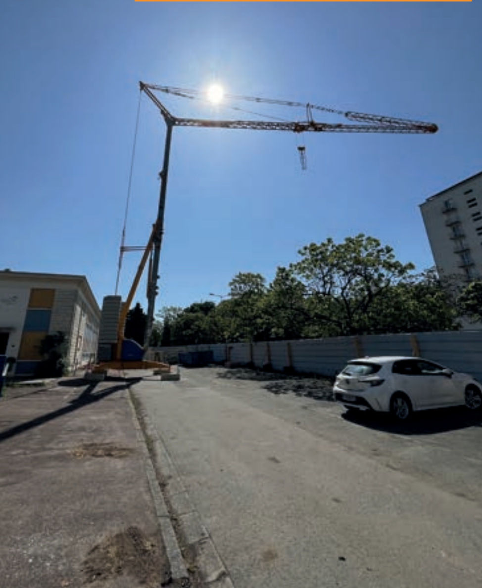
Travaux Clos Gaultier - Mai 2024
