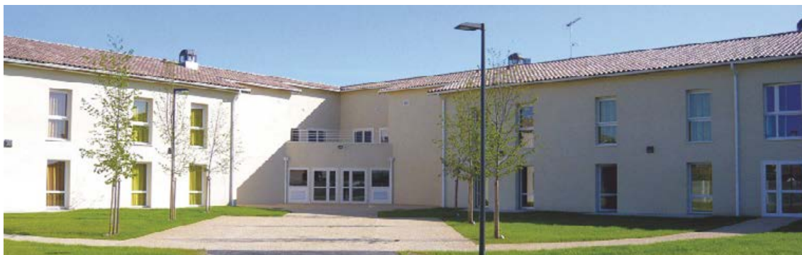
Construit par la SEM 47 pour le compte du groupe Medica, l'EHPAD de Sainte-Bazeille (47) compte 72 lits
